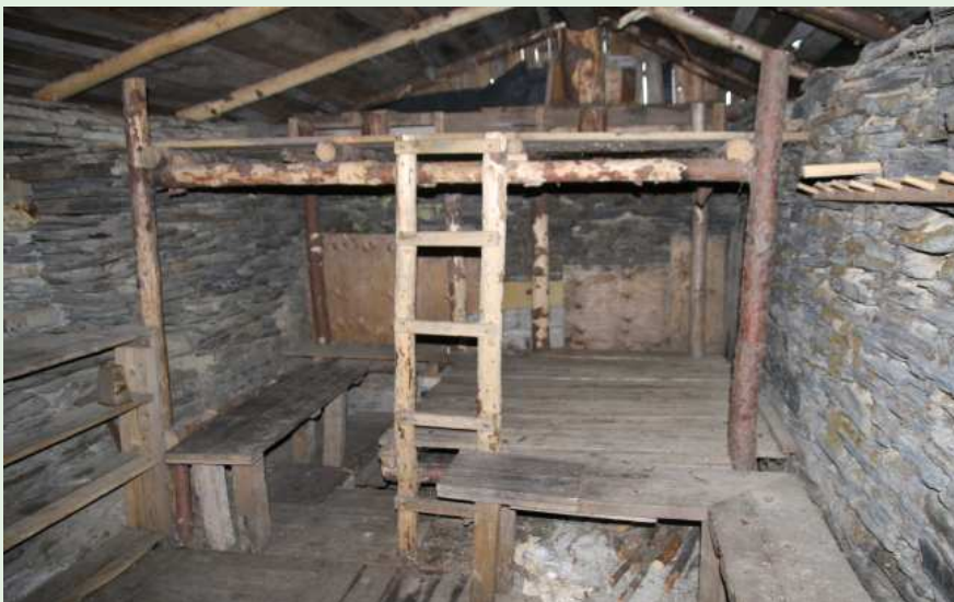
10. Interiér trampské boudy v oblasti „Šifer“ – břidlicových lomů na severní Moravě a ve Slezsku. Dřevěné palandy, lavice a krov jsou vestavěny do torza bývalé lomařské stavby z nasucho kladených břidlicových plátů.
