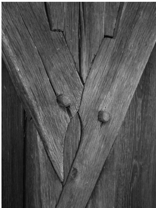
Detail hrázděné konstrukce artikulárního kostela v Hronseku. Přetisk z www.HisPam.sk .
