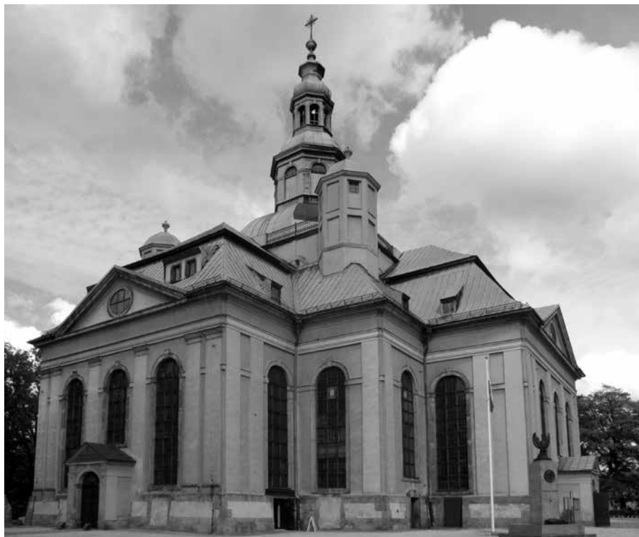
Kostel Sv. Kříže v Jelení Hoře, dnes římskokatolický vojenský posádkový kostel Povýšení sv. Kříže. Foto Z. R. Nešpor, 2013.
